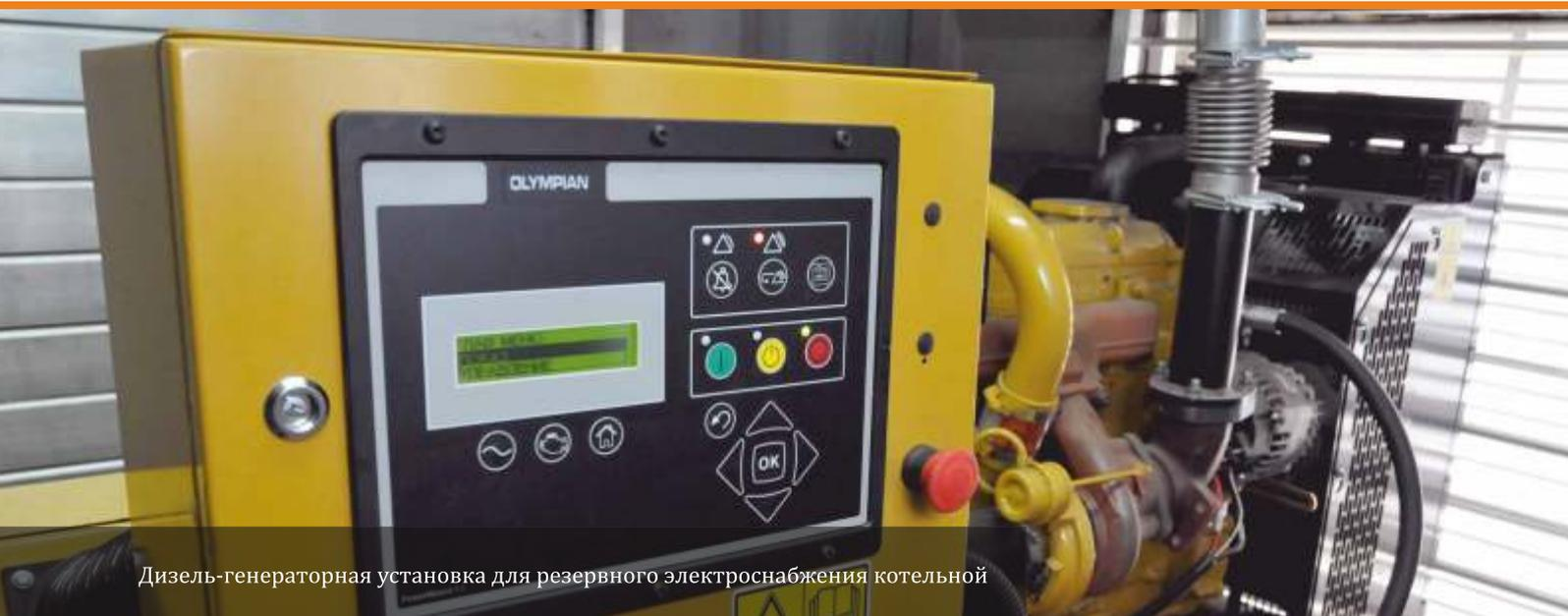
Дизель-генераторная установка для резервного электроснабжения котельной
