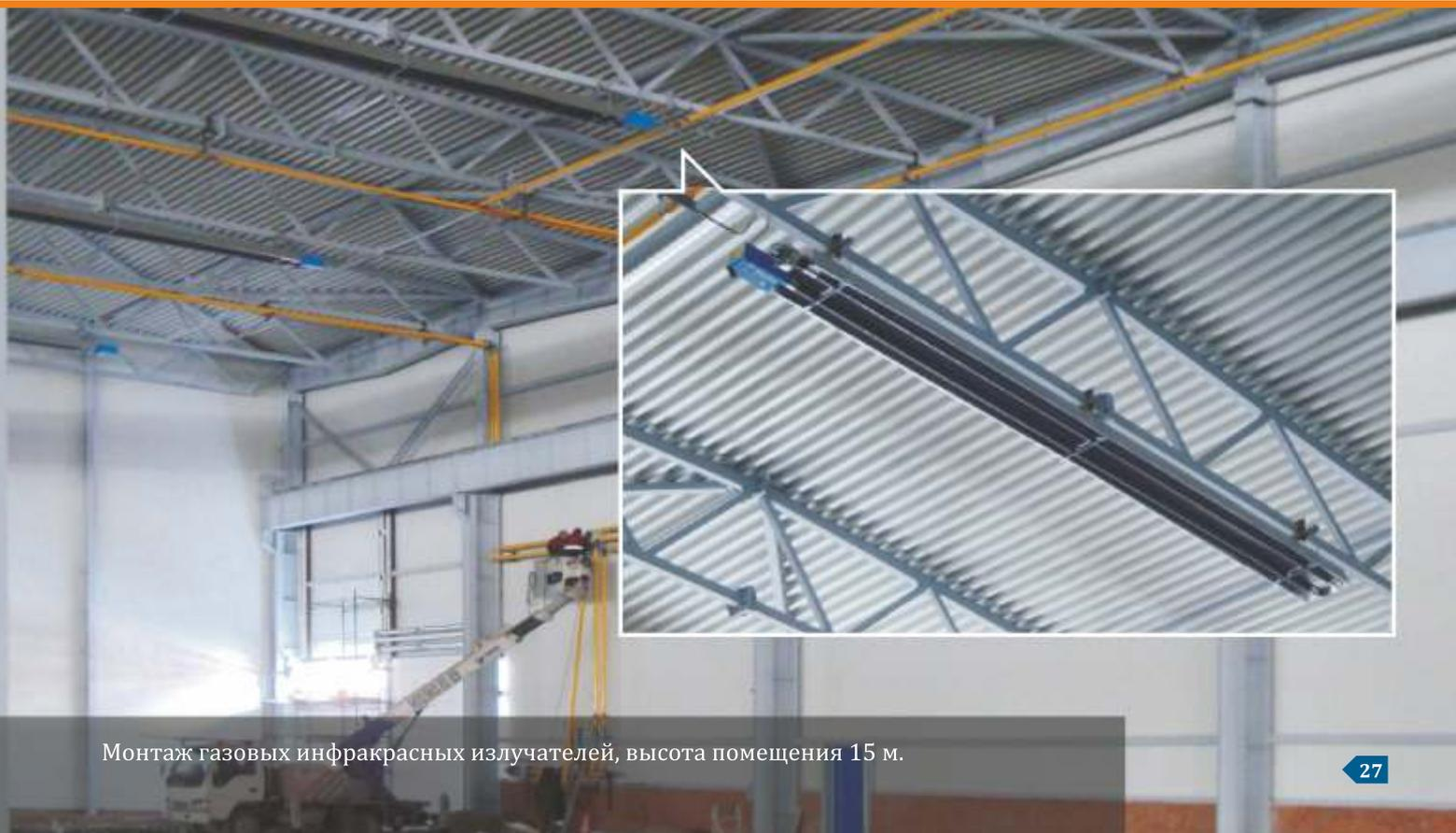
Монтаж газовых инфракрасных излучателей, высота помещения 15 м.
